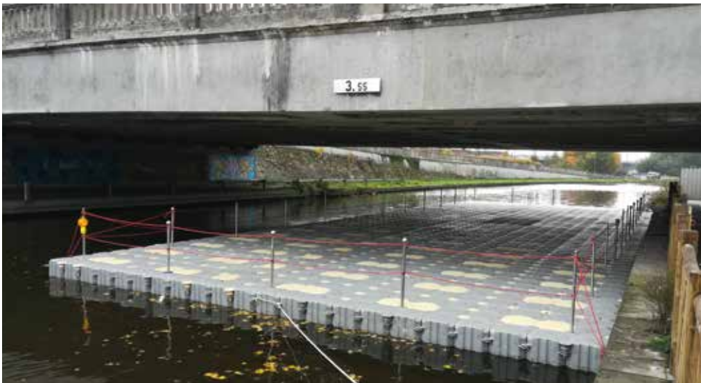
Plateforme de travail sous pont
