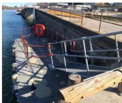
Passerelle sur mesure
