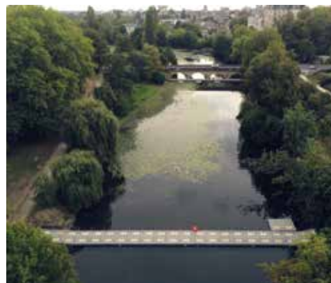
Pont temporaire pendant travaux
